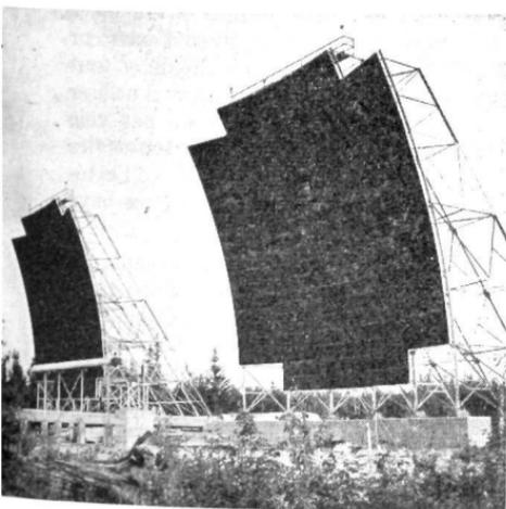
Installations massives d'antennes au terminus du système de diffusion troposphérique de Hay River (T. N.-O.); de semblables installations sont construites à Snare Falls, Port Radium et Lady Franklin Point.
